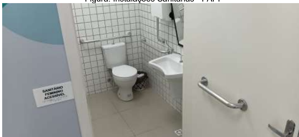
Figura: Instalações Sanitárias - FAPI
