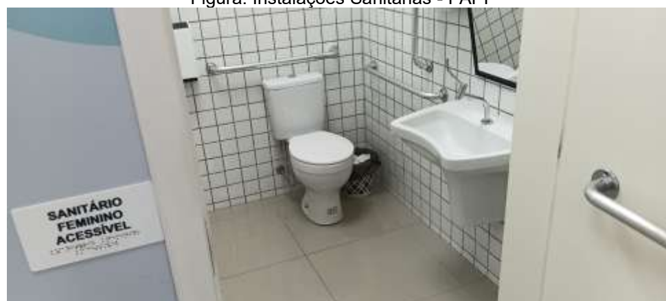
Figura: Instalações Sanitárias - FAPI
