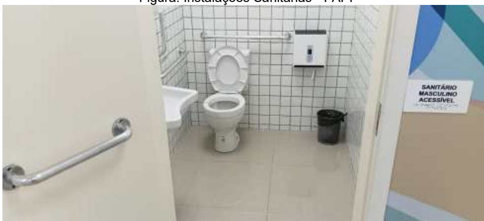
Figura: Instalações Sanitárias - FAPI
